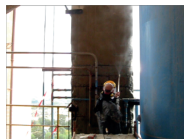
Rimozione intonaci e base coat.
