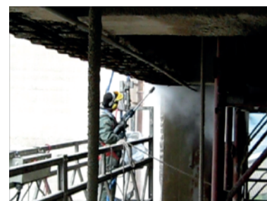
Rimozione cemento ammalorato sino a ferri di supporto
